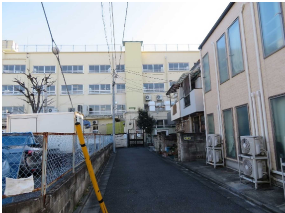
⑨北側道路(中央付近)
