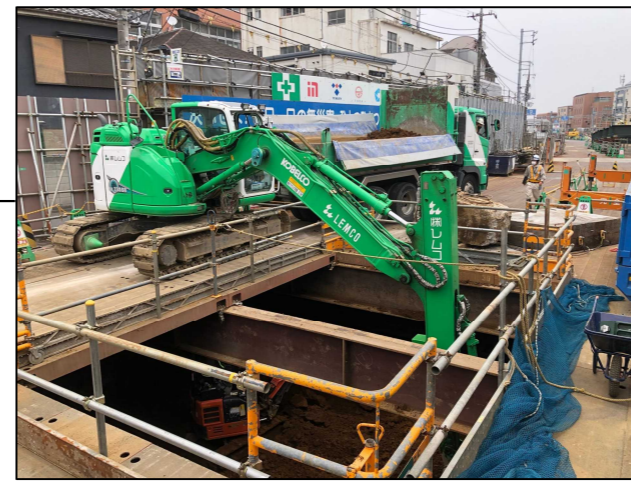
②掘削工（地上部）
