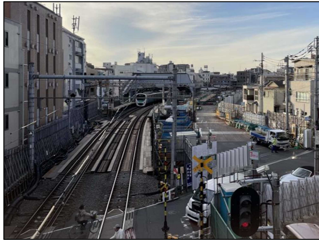
①新井薬師前駅 全景
