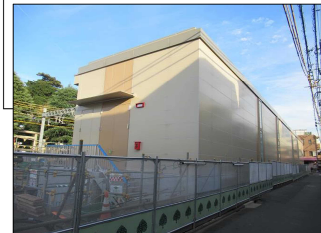
⑥変電所新築工
