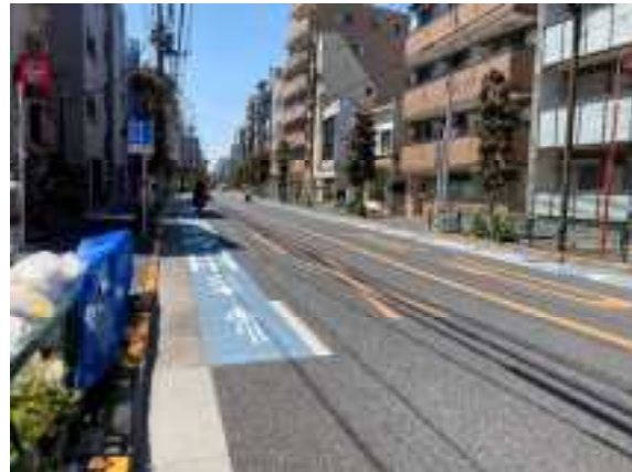
図 3.12 区内の整備事例(早稲田通り)
