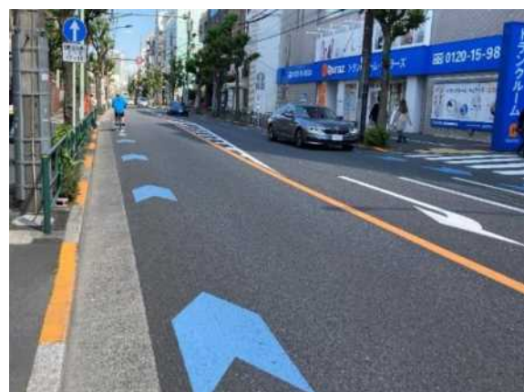
図 3.14 区内の整備事例(早稲田通り)
