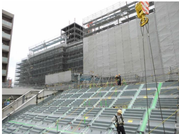
②西口デッキ階段部
