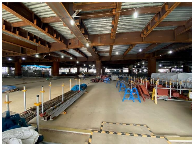
①中野駅桃園広場方面からの工事写真
