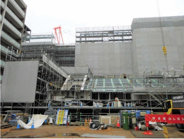
①中野駅桃園広場南側から南北通路を望む
