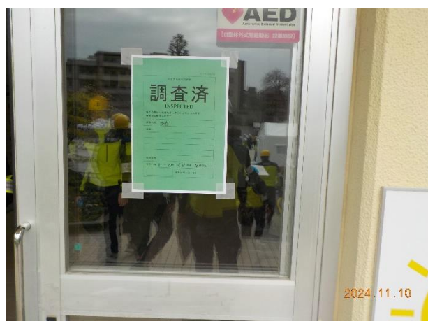
施設点検・応急危険度判定(桃園)
