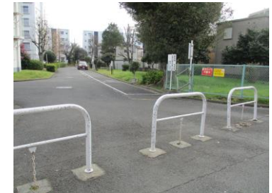
車止めが設置されている位置指定道路
