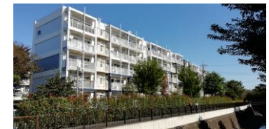
築60年以上経過した既存住棟
