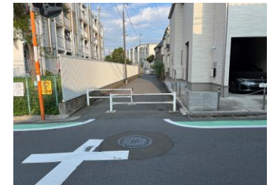
固定式の車止めが設置されている水路
