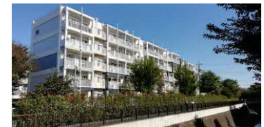
築60年以上経過した既存住棟
