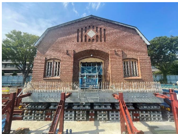
写真1 正門のジャッキアップ
