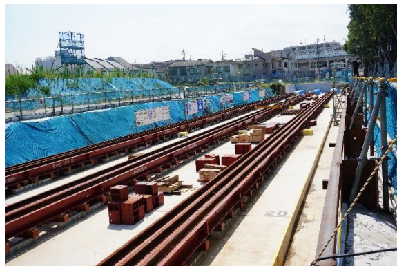
写真4 曳家経路と曳家先
