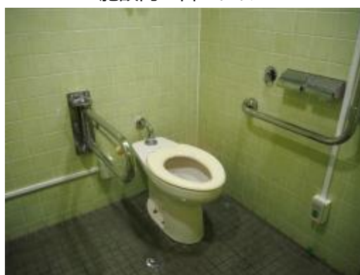
施設内の古いトイレ
