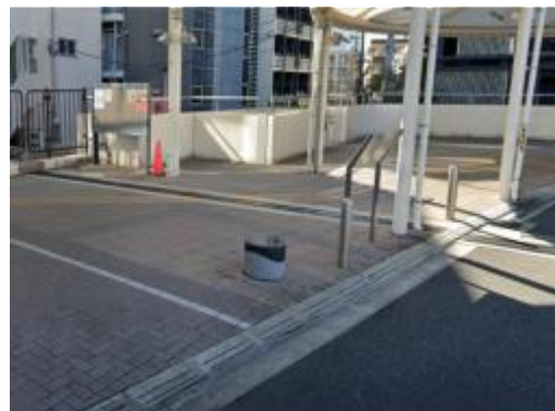
誘導用ブロックの設置不足
