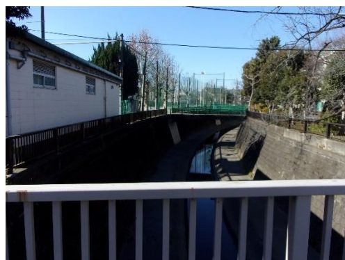
<妙正寺川沿いの様子>
