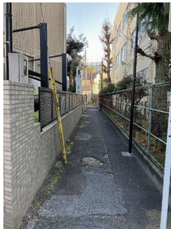
⑧北側道路から東側通路を見る
