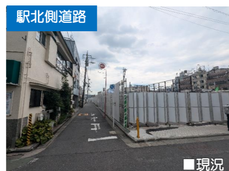
駅北側道路 ■現況 新たな顔となる駅北側道路沿道
