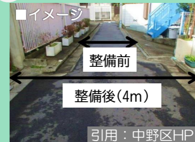
狭あい道路の拡幅整備
