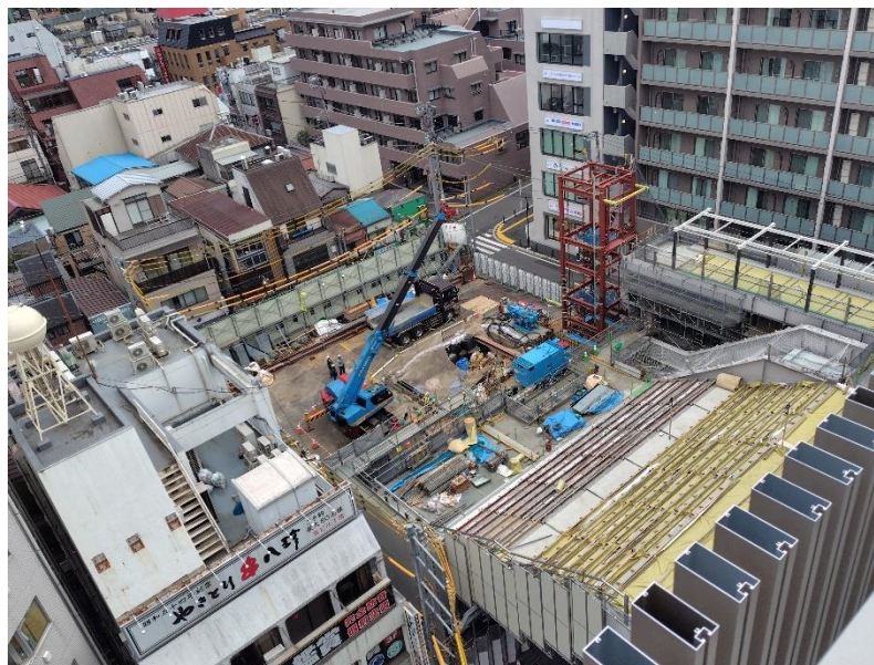
桃園広場側の工事状況
