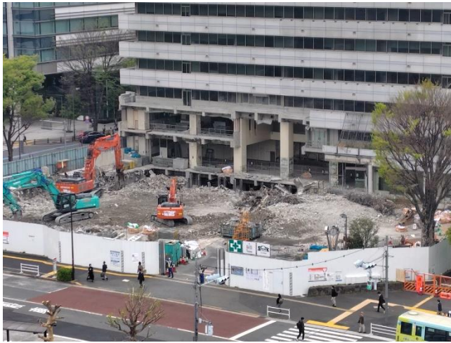
旧区役所低層棟の解体状況
