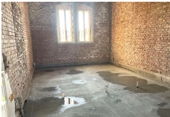
写真1 床面の設置状況
