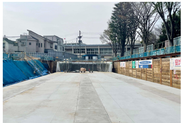
写真2 曳家経路と曳家先
