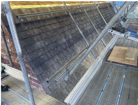
写真1 スレート瓦を葺いている様子
