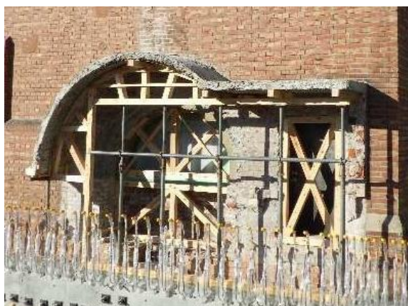
写真3 仕上げ材を解体した受付部分
