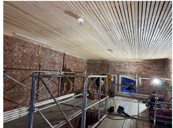
写真2 天井を修復している様子
