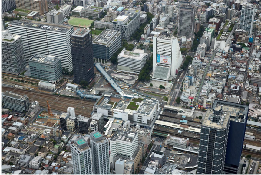
令和 8 年 8 月時点の工事進捗状況写真
