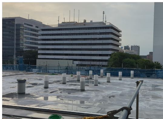
再開発シェルターの柱の下部の現況写真
