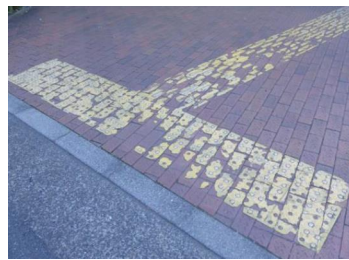
誘導用ブロックの摩耗、劣化
