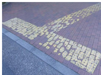
誘導用ブロックの摩耗、劣化
