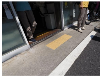
道路と入口の段差をなくするためのステップが滑りやすく傾斜が急
