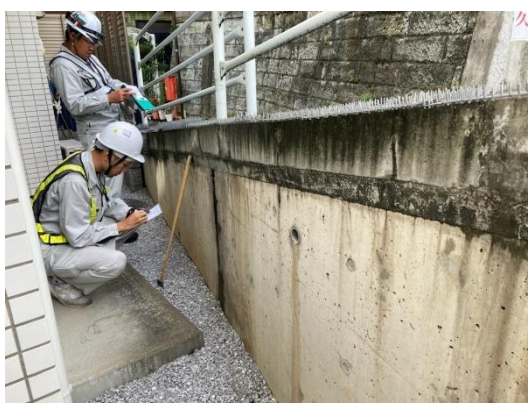
図 2-9 点検時の様子(擁壁)
