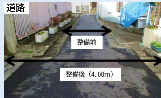
▲建物を後退して建替えることで狭い道路を解消 (中野区)
