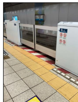
視覚障害者誘導用ブロック（落合駅）
