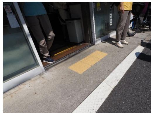
道路と入口の段差をなくすためのステップが滑りやすく傾斜が急
