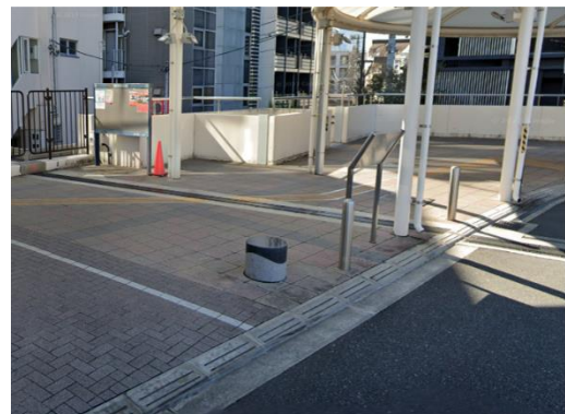
案内板への経路に誘導用ブロックを設置して欲しい
