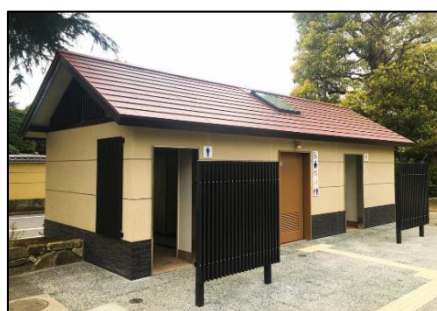
バリアフリートイレ (新井薬師公園)
