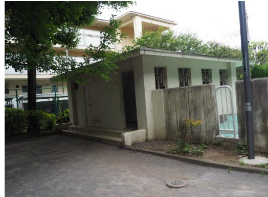
車いす使用者対応トイレが未設置 男女共用で和式のみ
