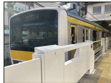
ホームドア*が整備されたプラットフォーム（東中野駅）
