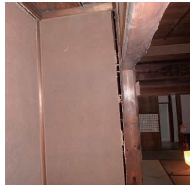
写真3 壁面の乖離
