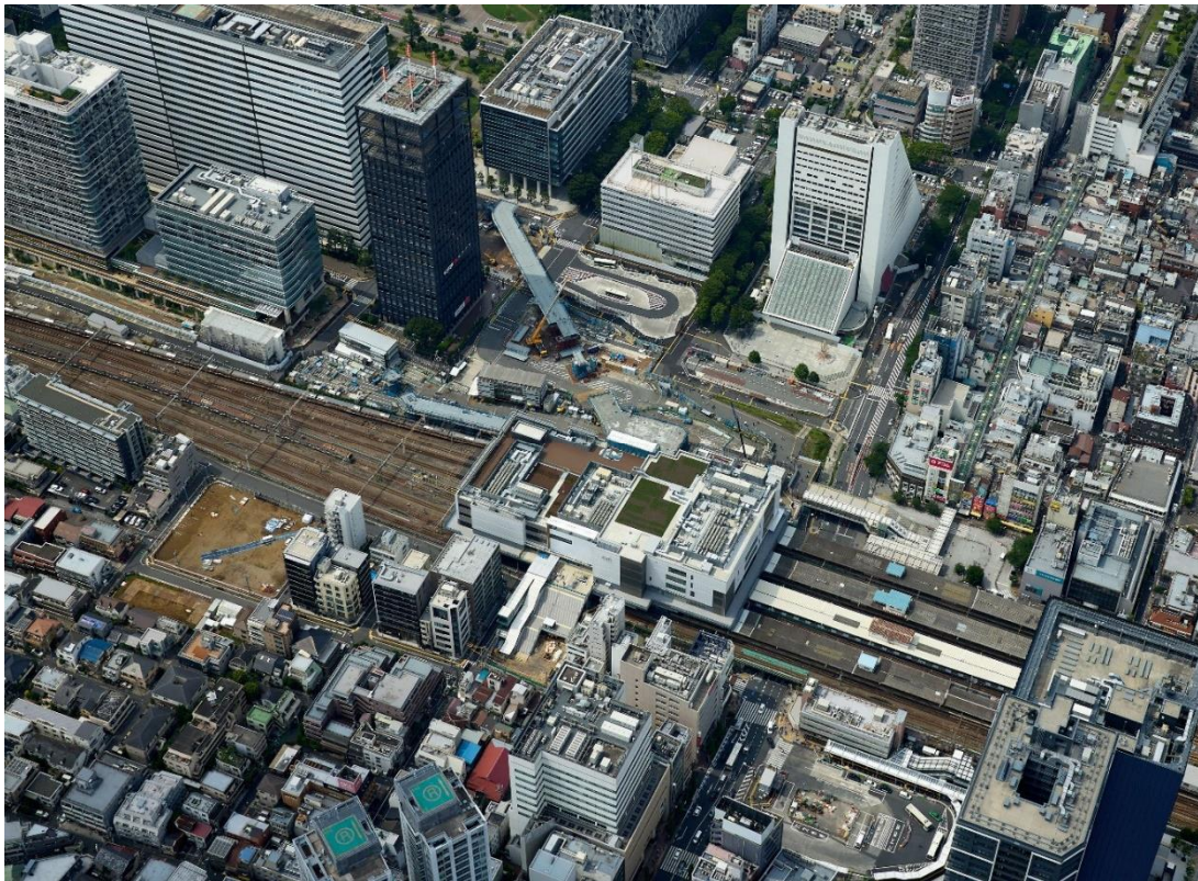
令和 8 年 6 月時点の工事進捗状況
